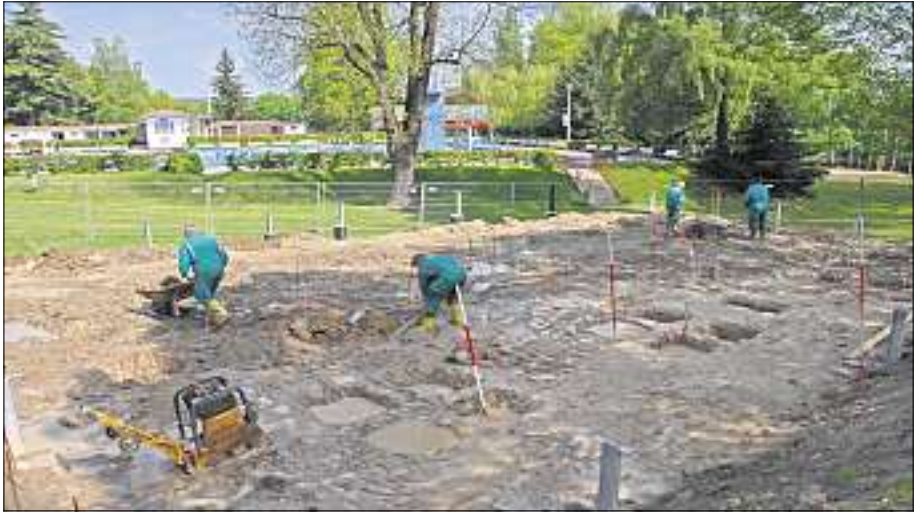
HARTE ARBEIT: Der viele Regen der vergangenen Wochen sorgte dafür, dass auf der Spielplatz-Baustelle Gummistiefel unverzichtbar sind. Foto: Thomas Ritter
